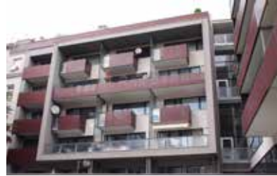
34. Balkone und Laubengänge BTA
