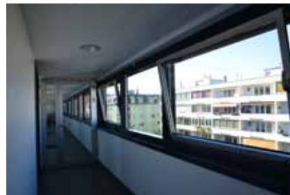
25. Erschließungsgänge mit Glasfassaden
