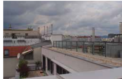
36. Blick auf gemeinschaftlich nutzbaren Dachterrassenbereich
