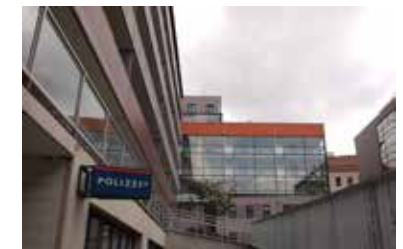
30. Polizeistation in BTB (Ansicht vom Innenhof)
