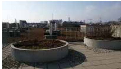
44. Gemeinschaftsbeete aus Kanalrohren
